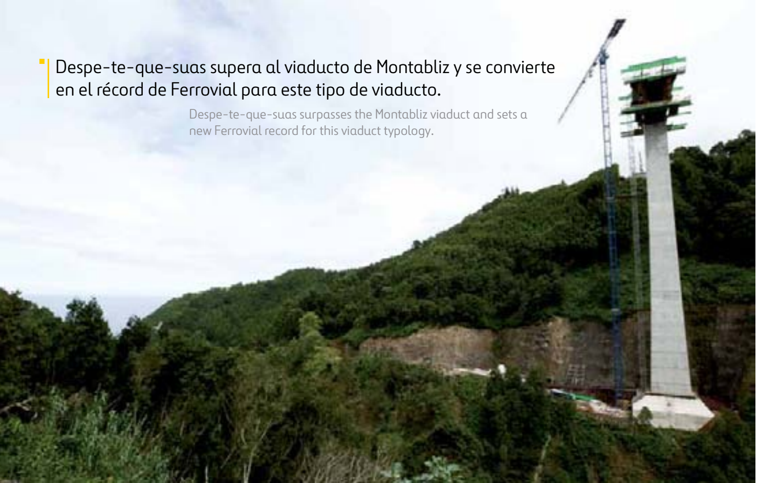
Vista panorámica del Viaducto Despe-te-que-suas que, con 185 metros entre pilares, marca un récord para Ferrovial. Panoramic view of the "Despe-te-que-suas" Viaduct, with 185 metres between pillars, that sets a new Ferrovial record.
