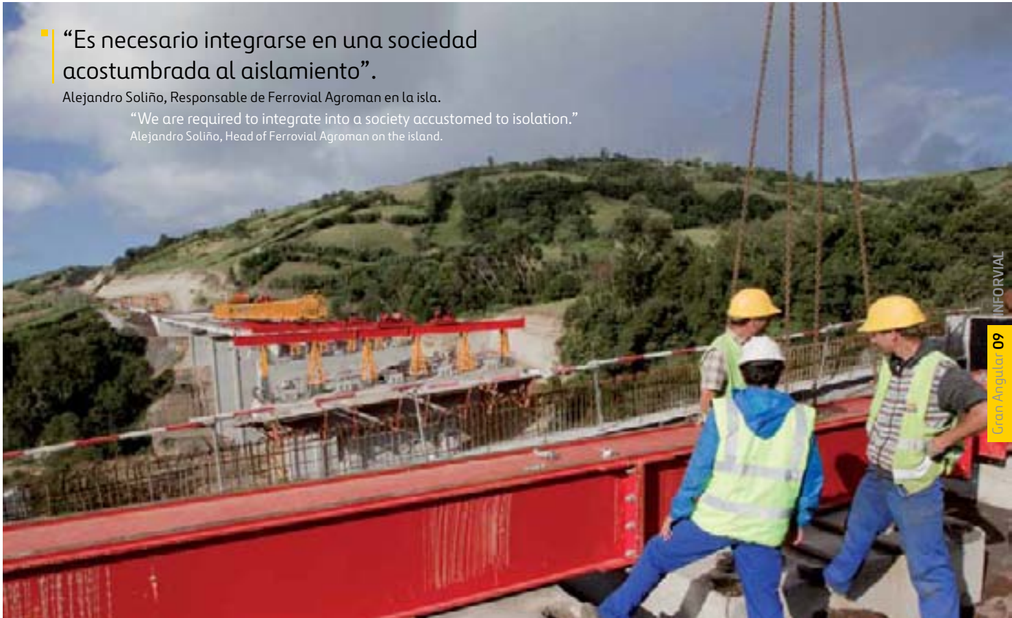
Construcción de un viaducto de vigas prefabricadas. Al fondo, el lanzador de vigas para su montaje sobre las pilas.
