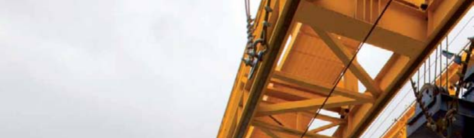
Construcción de la autopista Scut Azores en la isla de San Miguel, Portugal. Building of Scut Azores Highway on the Island of San Miguel.
