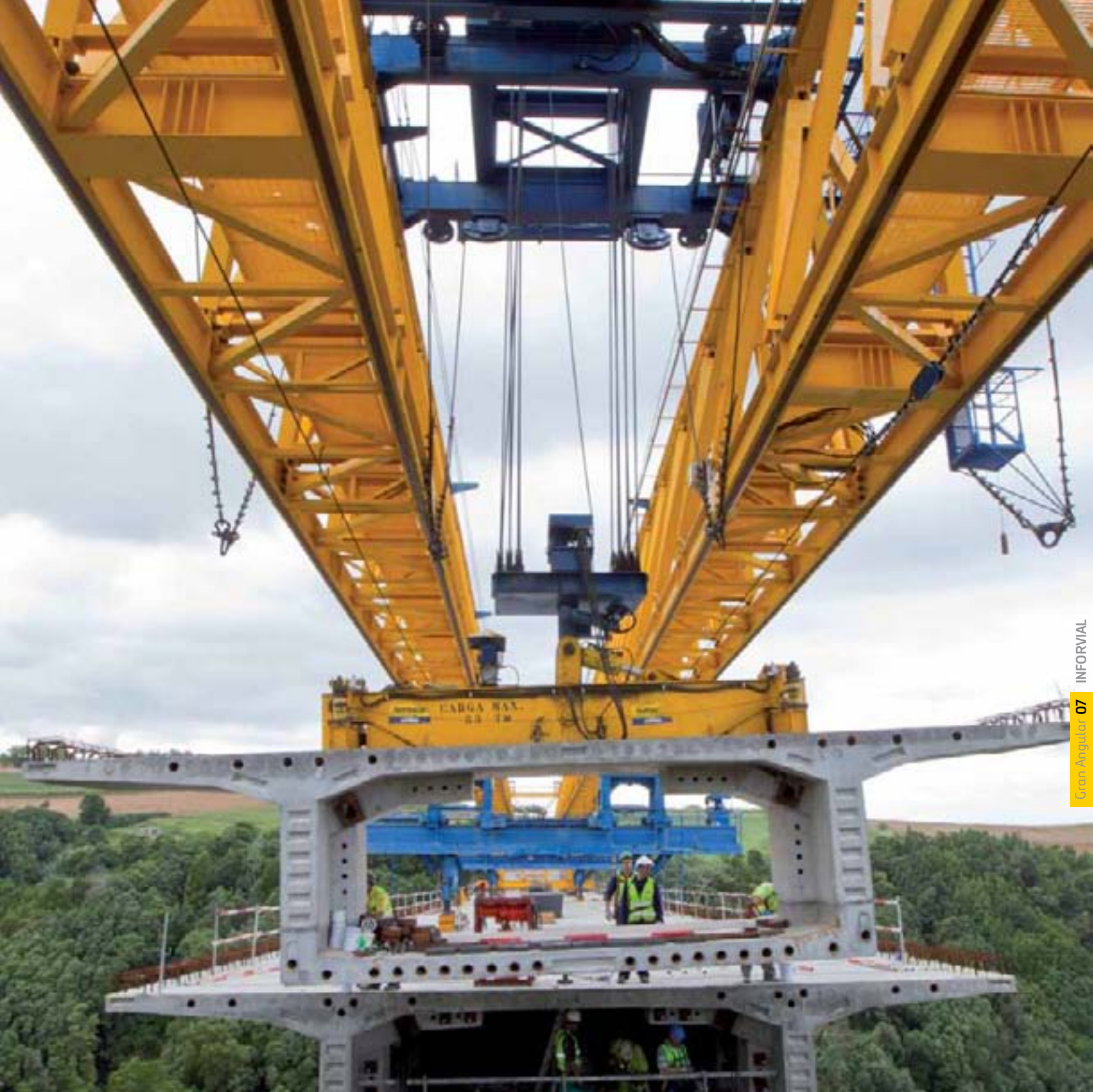
Colocación de dovelas en uno de los cuatro viaductos con tipología de tablero del eje nordeste. Installation of springers in one of the four viaducts being built with this road surface typology in the north-eastern axis.
