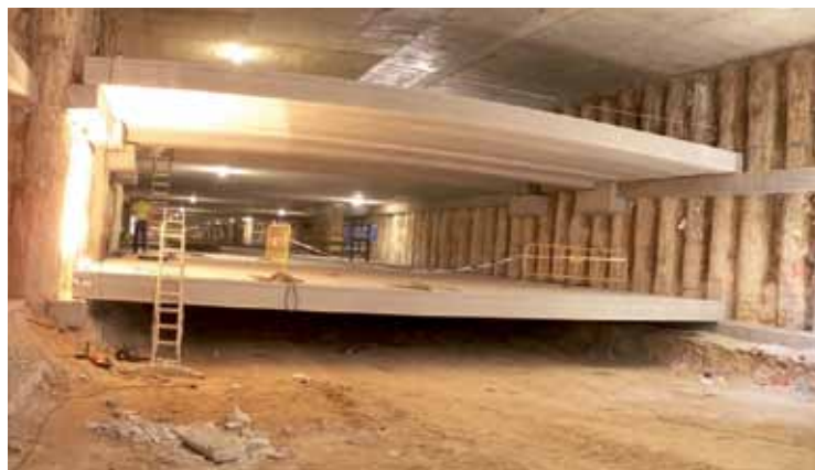
Uno de los aparcamientos de Serranopark durante la construcción de la infraestructura. One of the Serranopark car parks during the construction of the infrastructure.
