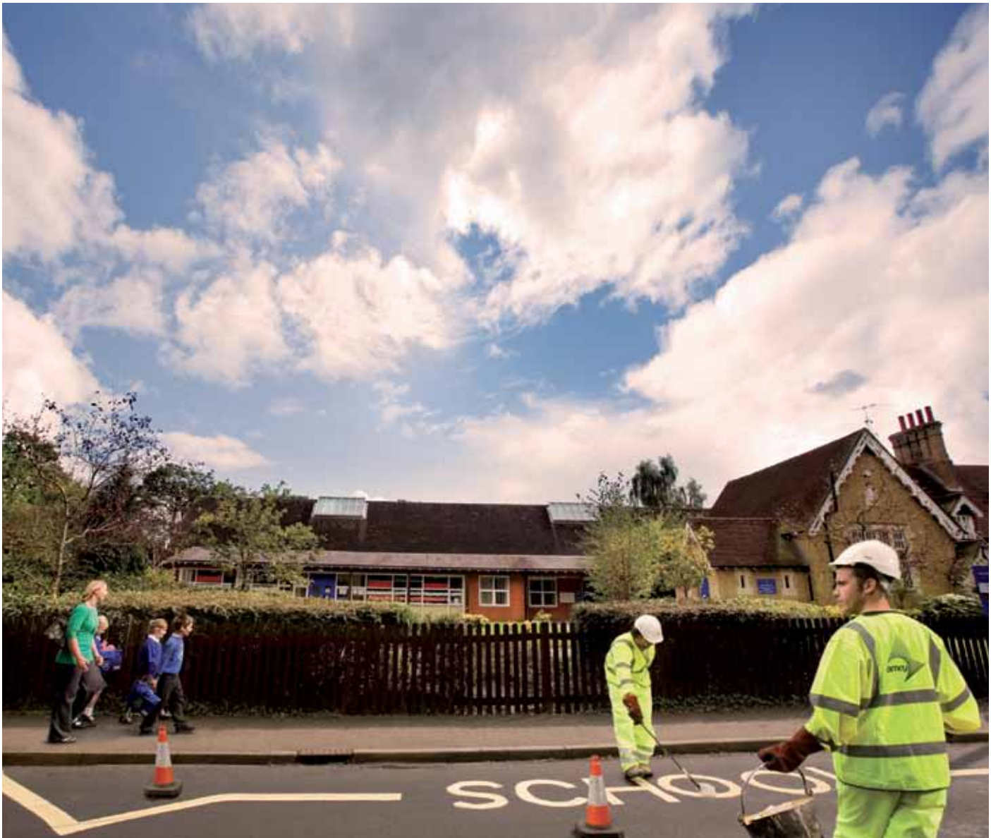
Varios empleados de Amey señalizan una vía en las cercanías de un colegio. Several Amey employees positioning the road signage in the vicinity of a school.
