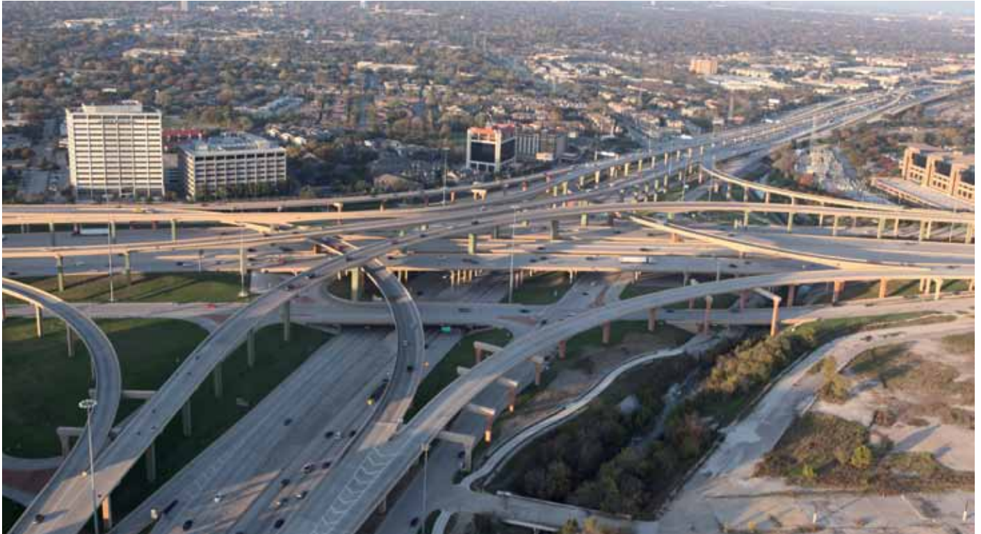
Autopista North Tarrant Express en Texas. North Tarrant Express in Texas.
