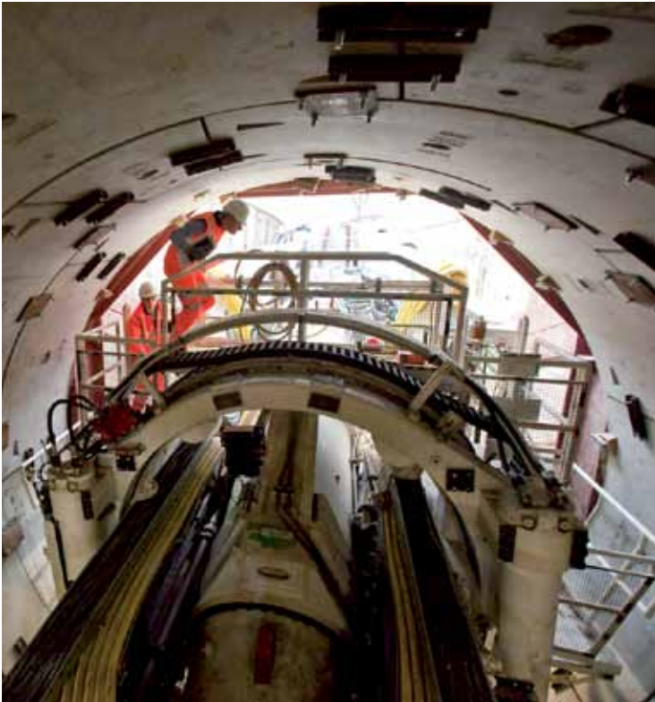
Tareas de excavación de los túneles entre Royal Oak y Farringdon. Excavation tasks for the tunnels between Royal Oak and Farringdon.
