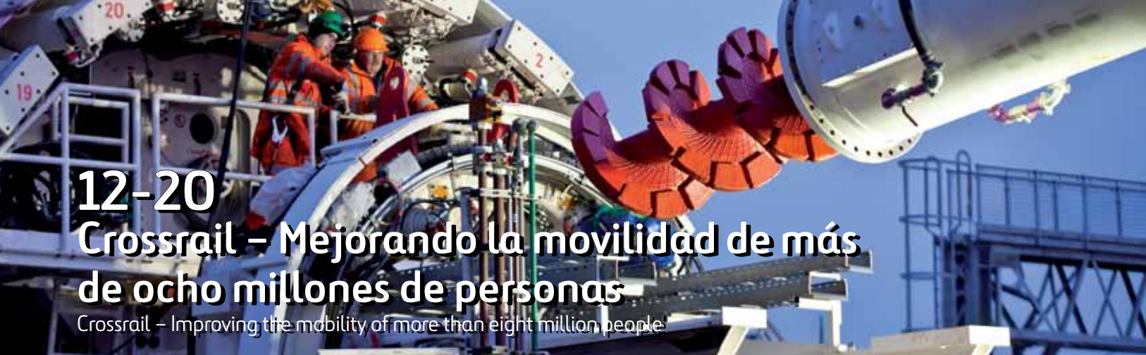
Cabezal de la Tuneladora de Crossrail situada en el parque de Westbourne, Londres. Crossrail Tunnel Boring Machine - cutterhead being installed at Westbourne Park, London.
