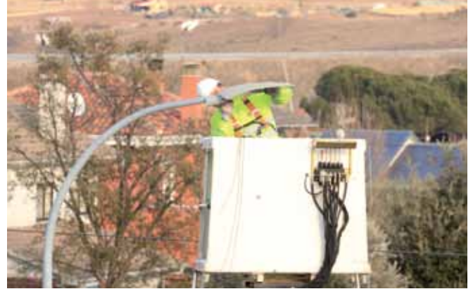
Trabajo de mantenimiento de luminarias. Lamppost maintenance work.
