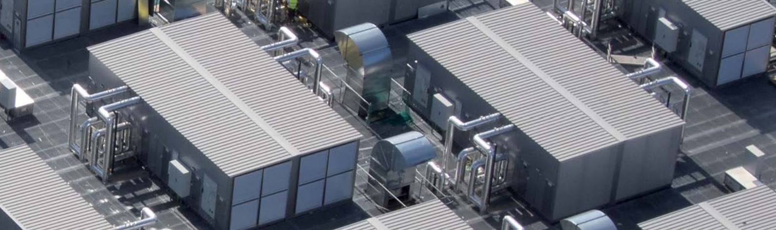
Centro de Procesamiento de Datos de Telefónica, Alcalá de Henares. Telefónica's Data Center, Alcalá de Henares, Spain.
