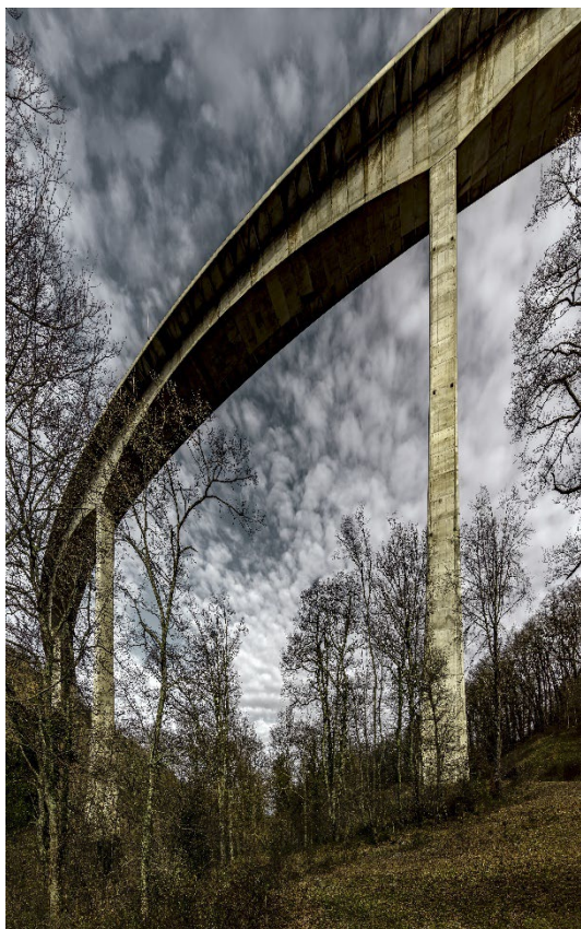
Viaducto de Montablitz, Cantabria, España
